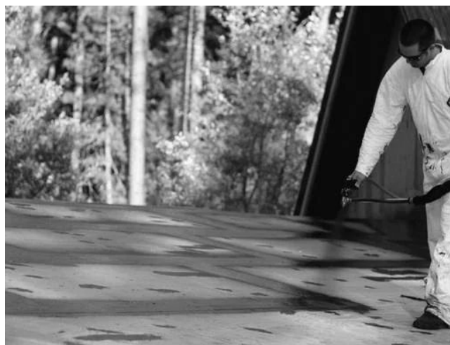
Fig. 2 Operario aplicando WetSuit® 2-Part sobre una cubierta
